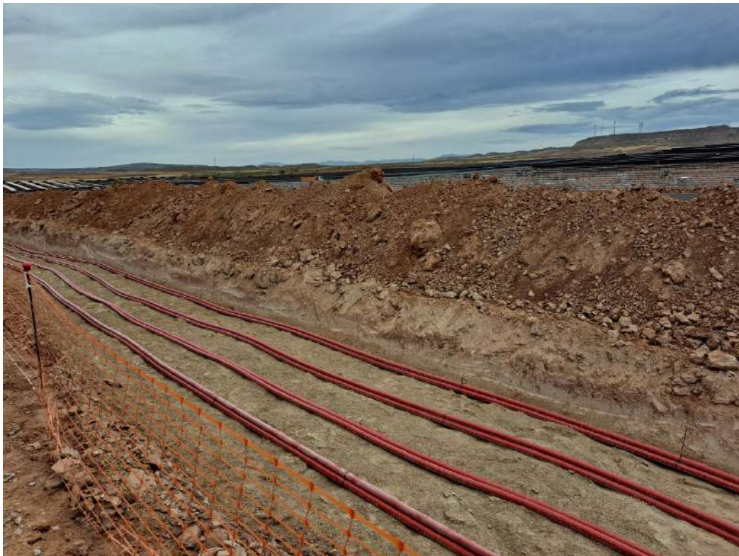
Foto 9. Tendido de cable soterrado
