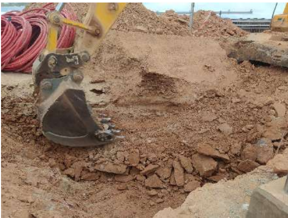
Fot 1 a 4. Zanja de BT y MT entre los sectores A5 y A7 de la PSFV Pitarco A
